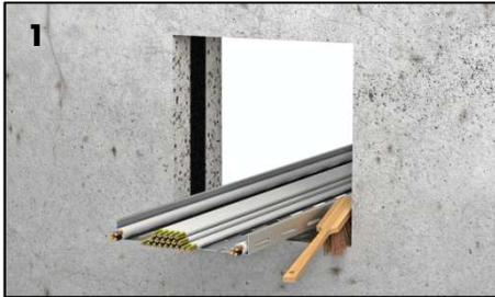
Pulire accuratamente l'apertura rimuovendo la polvere ed eventuali residui. Successivamente applicare il nastro intumescente autoadesivo (compreso in ogni confezione di cuscini): **a parete** il nastro deve essere applicato al centro dell'intradosso dell'apertura sul lato superiore e su quelli laterali, mentre **a solaio** a filo inferiore dell'intradosso dell'apertura (filo inferiore solaio) lungo tutto il perimetro dell'apertura stessa (vedere anche fig. 6).
